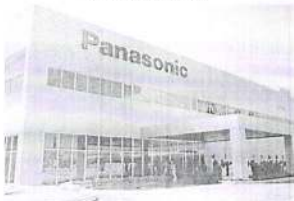
Nhà máy Panasonic
