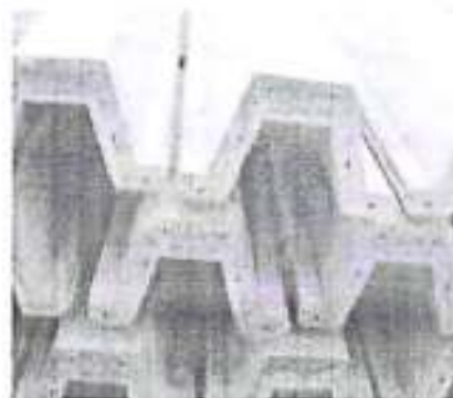
Cử dự ứng lực
