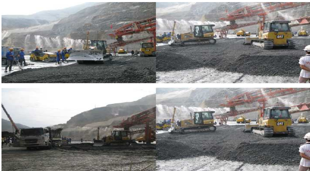
Hình 1: Tổ chức thi công bê tông RCC
