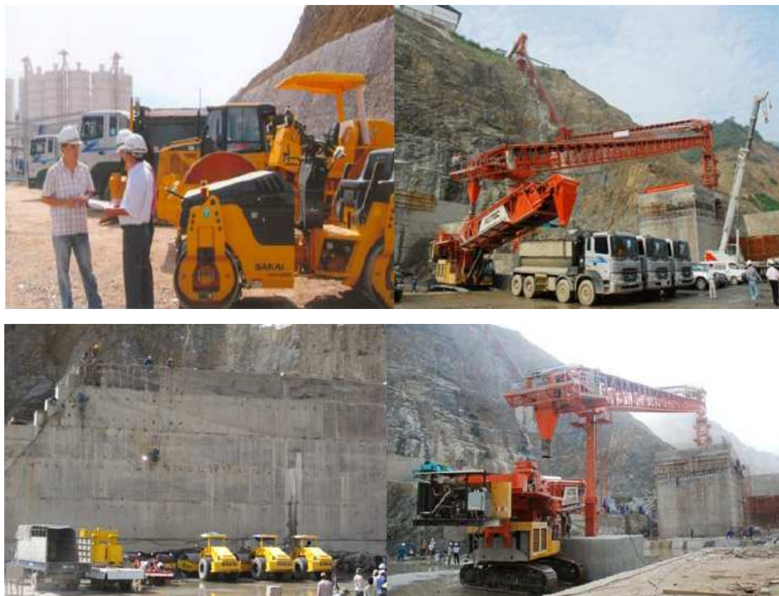
Nguồn: Công ty Cổ phần Licogi 16.6
