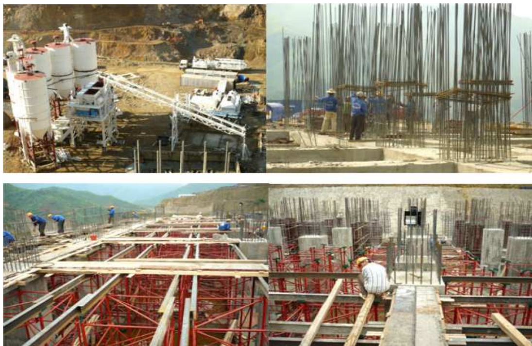
Hình 5: Thi công hạng mục phụ trợ bê tông RCC
