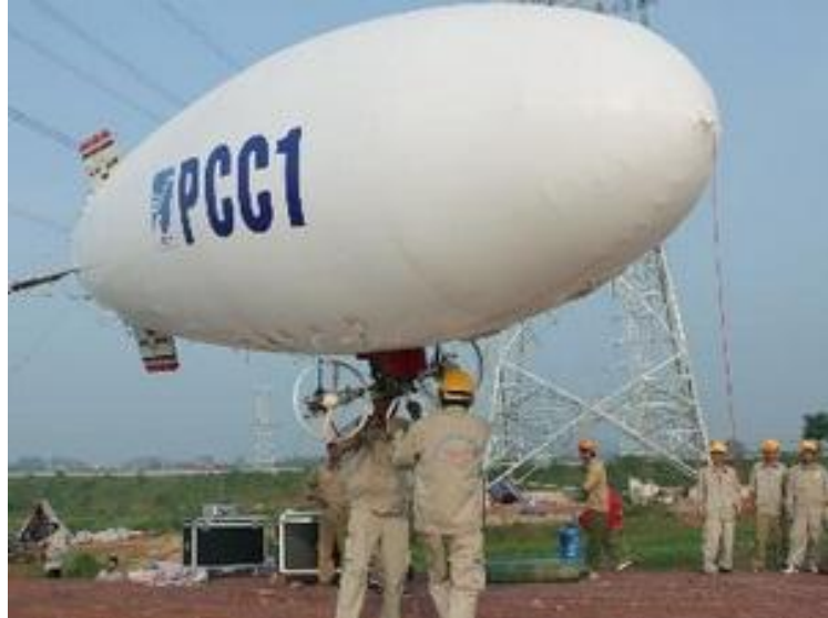
Hình 7 : Khinh khí cầu mang theo dây mồi chuẩn bị bay vượt sông
