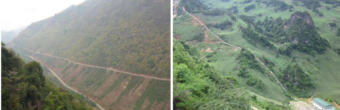
Hình 5: Đường ống dẫn nước đến tuyến năng lượng
