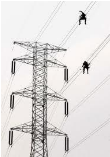
Đường dây 220KV Buôn Kuop – Đăk Nông
