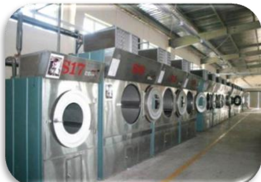
Hệ thống máy giặt công nghiệp
