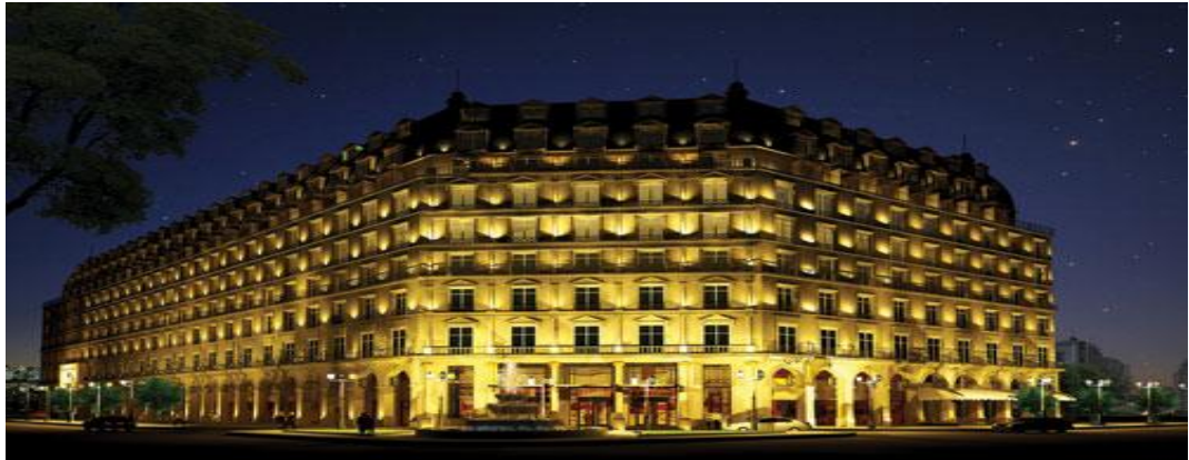
Hình 10: Dự án số 10 Trần Nguyên Hãn
